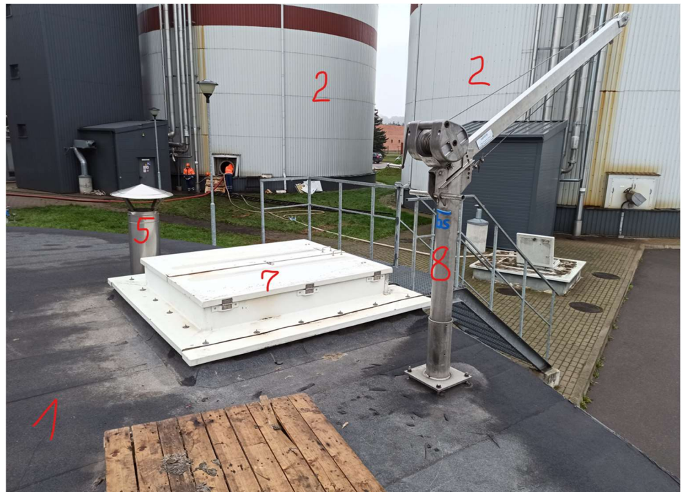
1 – dumblo talpykla 1000 m 3 ; 2 – dumblo pūdytuvai; 3 – biofiltras; 4 – ultragarsinis ir elektroinis vandens lygio jutikļi; 5 – alsuoklis oro pritekējimui; 6 – alsuoklis oro nuvedimui j biofiltrā; 7 – dangtis maišyklei iškelti; 8 – maišyklēs iškēlīmo jrenginys
